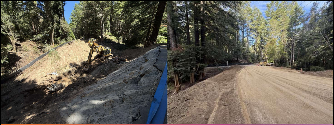
Wurr Road Culvert Repair
